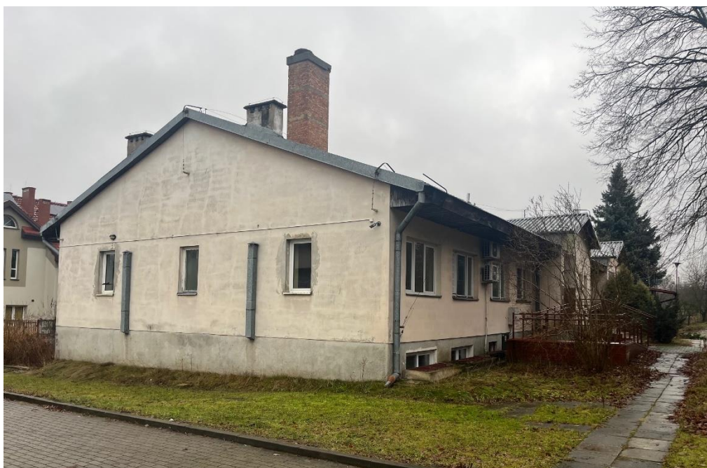
Fot. 1. Widok od strony południowo-zachodniej
