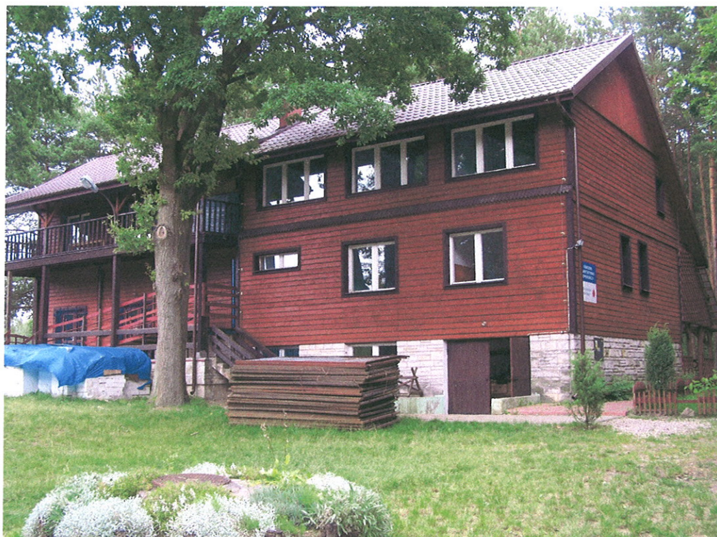
Widok ogólny budynku od strony zachodniej
