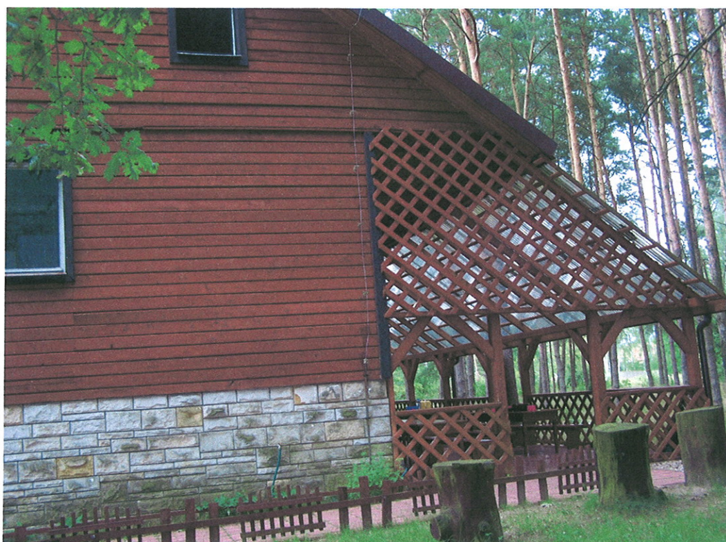
Fragment elewacji południowo-zachodniej z widokiem na zadaszony taras na południowo-wschodniej ścianie budynku.
